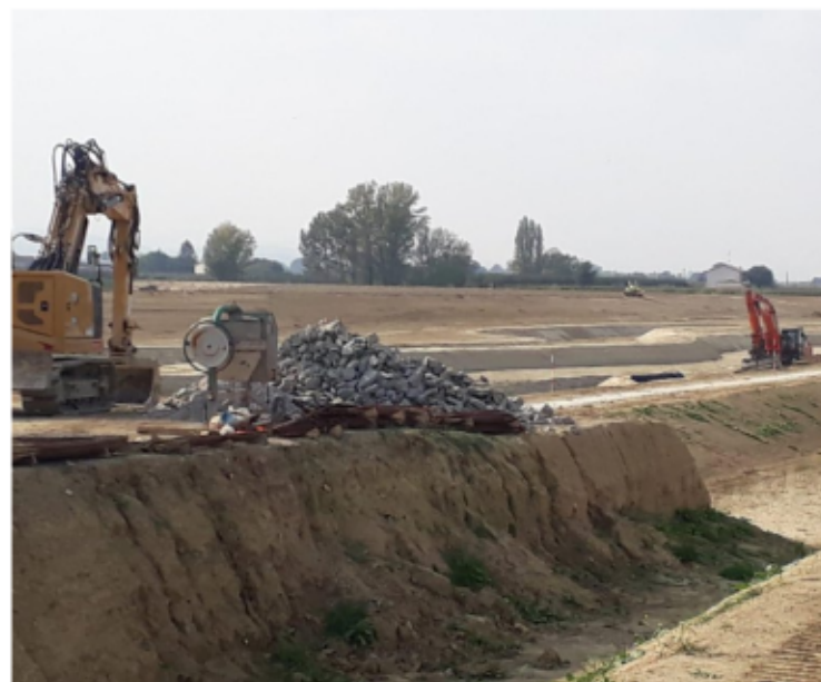
Le opere in corso per la realizzazione del nuovo bacino di laminazione
